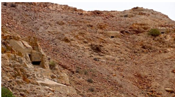
Ambocto en 2011. Quelques-unes des embrasures pour armes automatiques desservies par le tunnel. Un observatoire affleure sur l'éperon, à droite de la vue.
