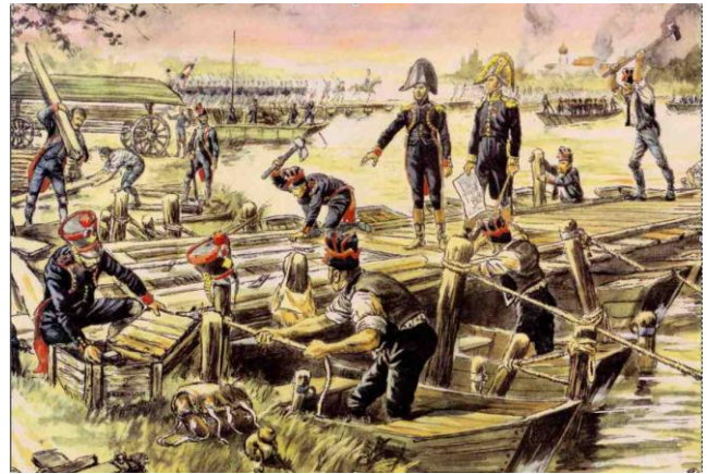
Pontonniers en action sur l'île de Lobau. Arrimage d'un pont de bateaux. Au second plan, un chariot portant une embarcation de type Gribeauval. Gravure musée du Génie
