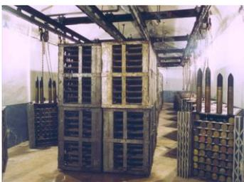
**Les soutes** aux artifices et munitions (4000 coups par pièce de 75mm, 200 000 cart. par tourelle de mitrailleuses, etc.). La manutention est facilitée par des monorails suspendus jusqu'aux quais de la gare. Les munitions sont réparties près des pièces (M3), au pied des blocs (M2) et dans les magasins de l'ouvrage (M1).
