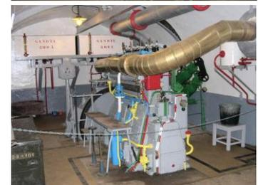
**La filtration/ventilation** - En situation de combat chaque bloc est autonome. Les entrées sont fermées par des portes étanches et l'ouvrage mis en surpression. L'air aspiré à l'extérieur est filtré et pulsé dans le fort par des gaines. L'air vicié est refoulé.
