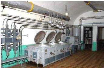
**Les cuisines** sont équipées d'appareils de cuisson fonctionnant à l'électricité – installations sans équivalent dans le domaine civil à l'époque – A proximité, magasins à vivres et chambre froide.
