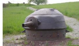
Tourelle STG démontable pour mitrailleuse M35
