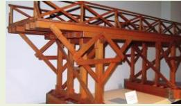
Pont de palées (pilots enfoncés dans le sol) protégées par des "cribs" (caissons de bois remplis de pierraille).
