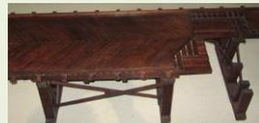
Ecorché de pont sur chevalets préfabriqués s'appuyant sur le fond de la coupure par une semelle.
