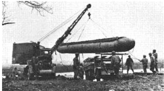
*Grue sur chassis Coleman en cours de manipulation d'un flotteur destiné à un pont Treadway – offensive de la Ruhr – mars 1945*
