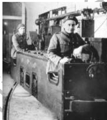
*Sapeurs du 15<sup>e</sup> RG servant un locotracteur électrique Schneider-Westinghouse-Vétra.*
